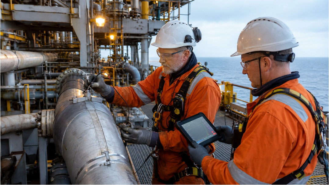
Abbildung 1: Zustandsbasierte Offshore-Inspektion mit UT-Messung und digitalem Anomalienabgleich.
